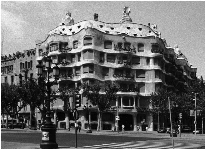
Figure 2.4. Casa Milà, Barcelona, 1906-1912. Antoni Gaudí, architect.
