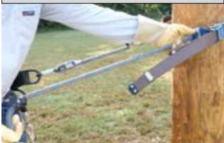
Figura 14: Mover el ajustador de la cuerda hacia el poste
