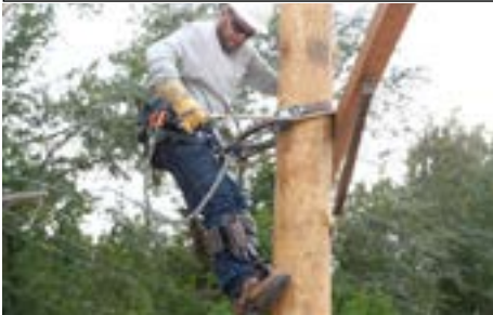
Illustration 22 : Installation de la corde secondaire
