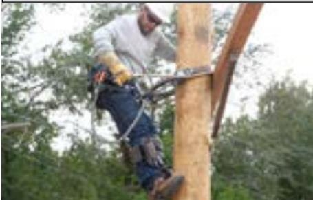
Figura 22: Instalación de la cuerda secundaria
