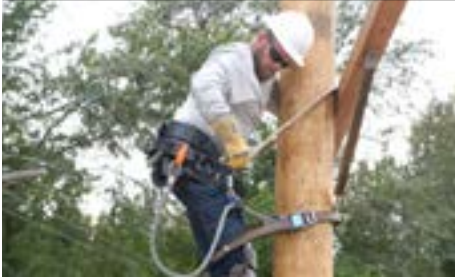
Figura 20: Instalación del dispositivo de cuerda secundaria
