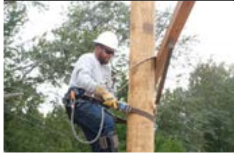
Illustration 23 : Installation du WPFRD sous un obstacle
