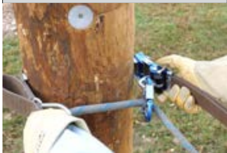
Illustration 8 : éloigner l'ajusteur de sangle du poteau
