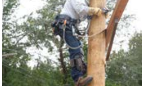
Figura 21: Conexión de WPFRD sobre obstrucción
