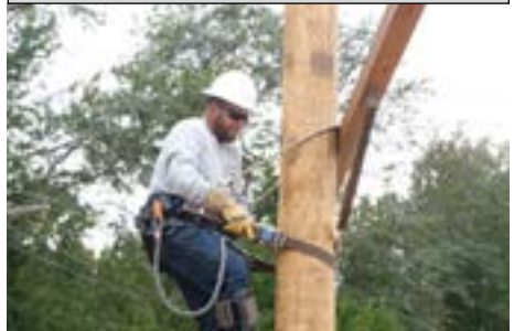
Figura 23: Instalación de WPFRD debajo de la obstrucción
