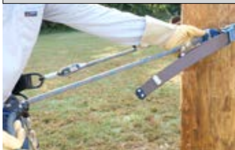
Illustration 14 : Déplacement de l'ajusteur de corde vers le poteau
