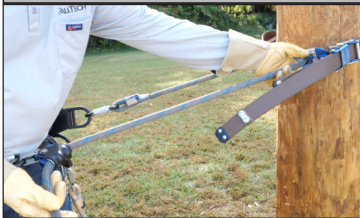
Figura 14: Mover el ajustador de la cuerda hacia el poste
