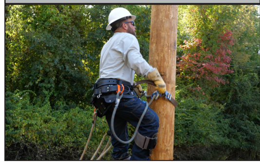
Illustration 19 : Hauteur de la sangle pour le repositionnement
