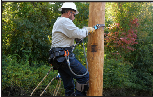
Illustration 18 : Position de levage de la sangle
