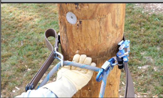
Illustration 13 : Orientation acceptable de la corde intérieure
