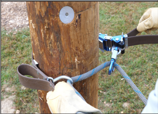
Figura 7A: Mover el ajustador de la correa hacia el poste
