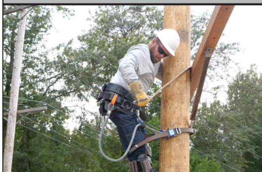
Illustration 20 : Installation du dispositif à câble secondaire
