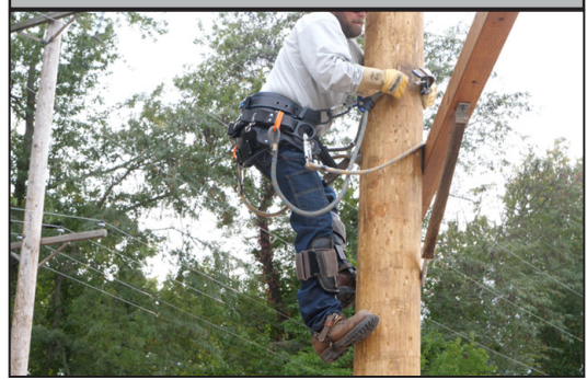
Illustration 21 : Connexion du WPFRD par-dessus une obstruction
