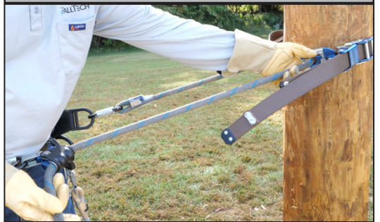
Illustration 14 : Déplacement de l'ajusteur de corde vers le poteau
