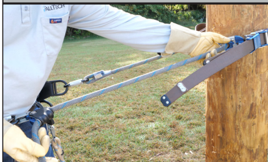
Illustration 14 : Déplacement de l'ajusteur de corde vers le poteau
