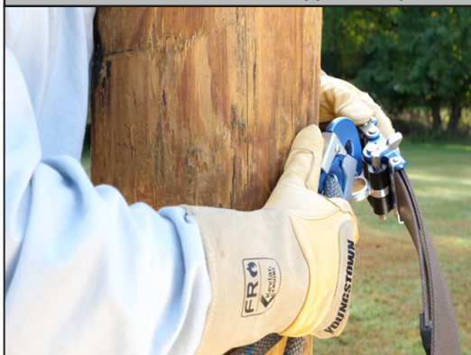
Illustration 6 : Connexion de l'appareil au poteau
