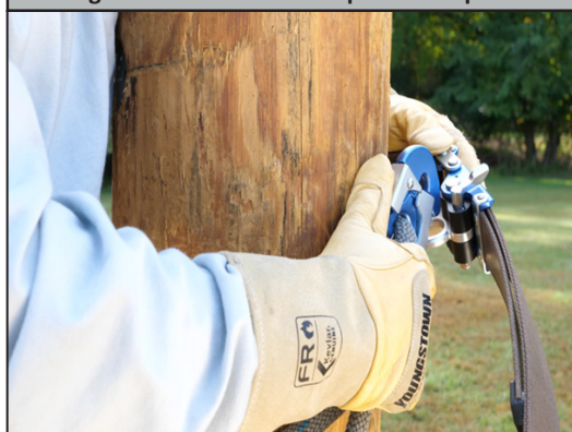
Figura 6: Conexión del dispositivo al poste
