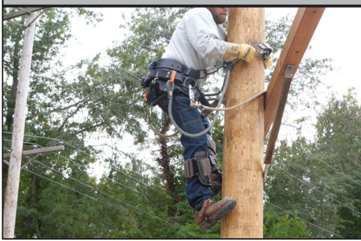
Illustration 21 : Connexion du WPFRD par-dessus une obstruction
