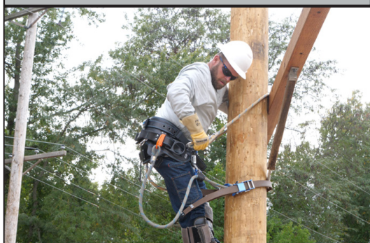
Illustration 20 : Installation du dispositif à câble secondaire
